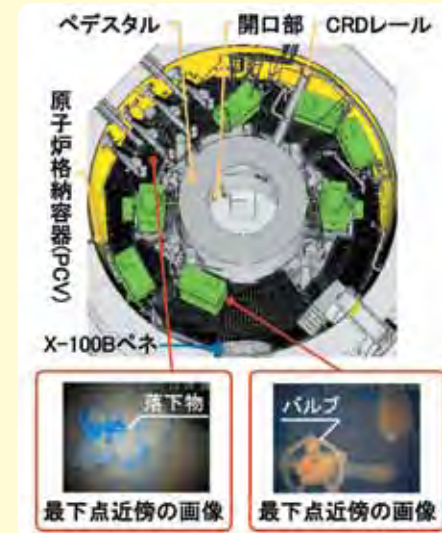
1号機PCV内部調査の状況
