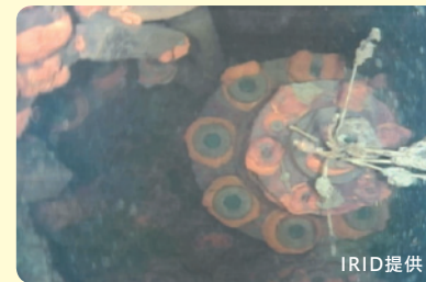
3号機原子炉 格納容器内の様子 IRID提供
