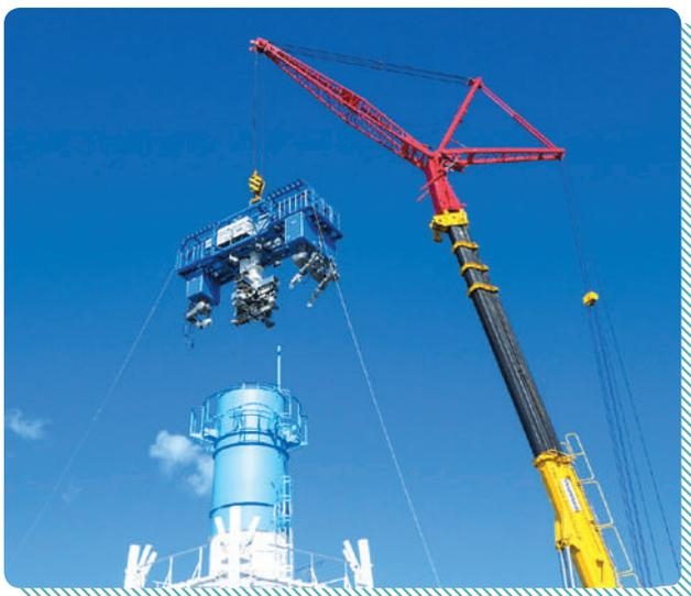
解体装置をクレーンで吊り下げ、ロボットを遠隔で操作して各部位を切断する
