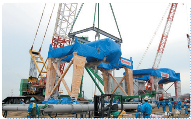
3号機の燃料取扱機・クレーンの搬入の様子
