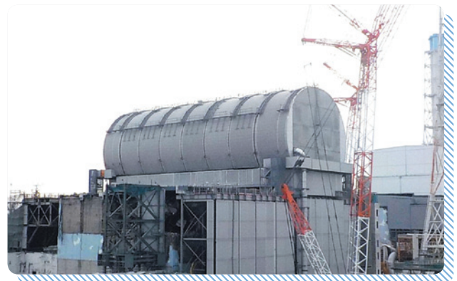
3号機燃料取り出し用カバーが設置された全景
